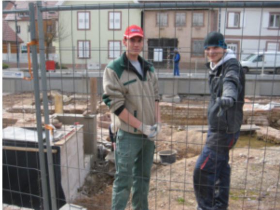
Eric Müller (rechts) aus Neuenkirchen bei Greifswald mit seinem Gastgeber Xavier auf der Baustelle: Restauration einer altrömischen Badeanlage.
